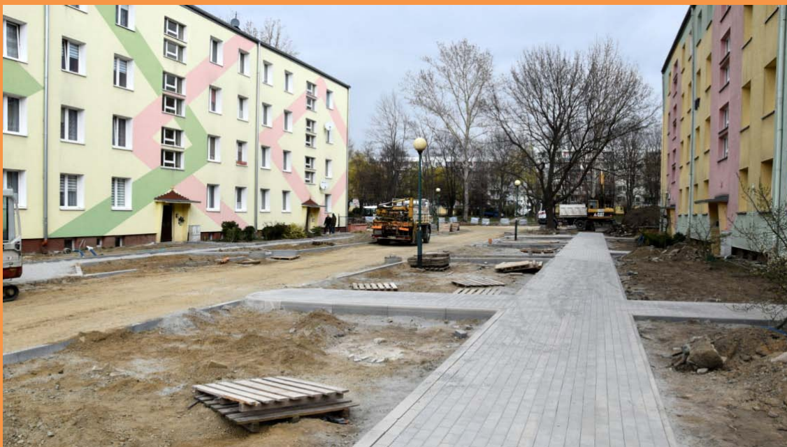
Modernizacja infrastruktury drogowej na os. Kolorowym
