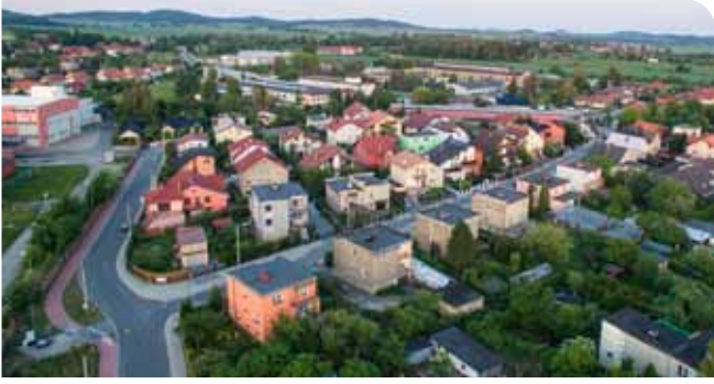
Przebudowa ul. Wierzbowej, Staffa, Zamenhofs oraz części ul. Andersa. Koszt inwestycji – 2 mln 442 tys. zł
