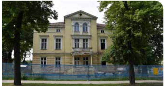
Budowa Centrum Seniora. Koszt inwestycji – 8 mln 936 tys. zł, pozyskane środki – 7 mln 109 tys. zł
