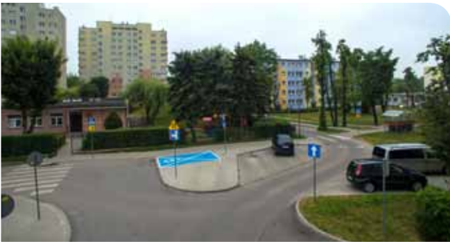
Budowa tęcznika i przebudowa drogi na os. Błękitnym (od ul. Korczaka do Szkoty Podstawowej nr 5). Koszt inwestycji – 716 tys. zł
