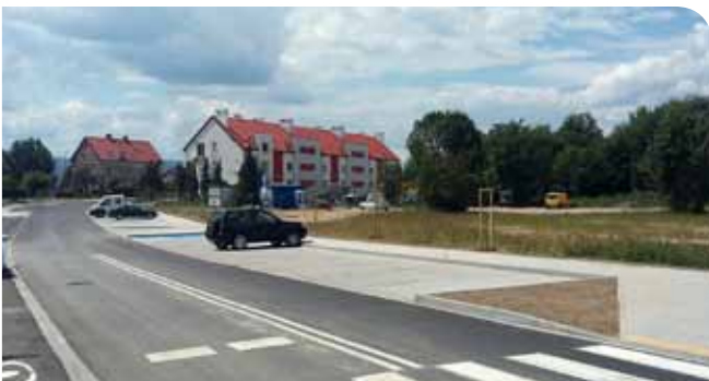
Budowa drogi i TBS-u przy ul. Sowiogórskiej. Koszt inwestycji - 6 mln 475 tys. zł
