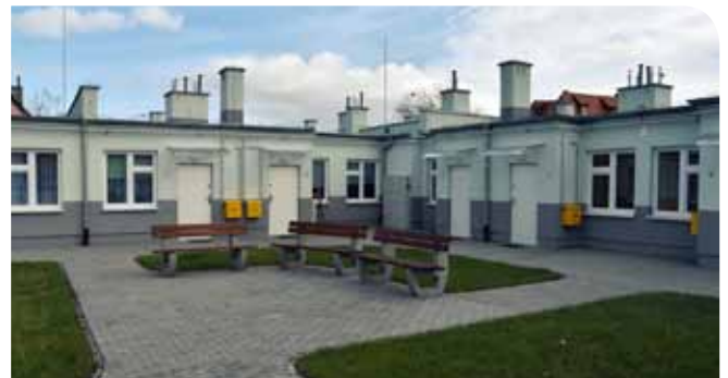
Budowa mieszkań komunalnych przy ul. Złotej. Koszt inwestycji – 1 mln 983 tys. zł, pozyskane środki – 876 tys. zł
