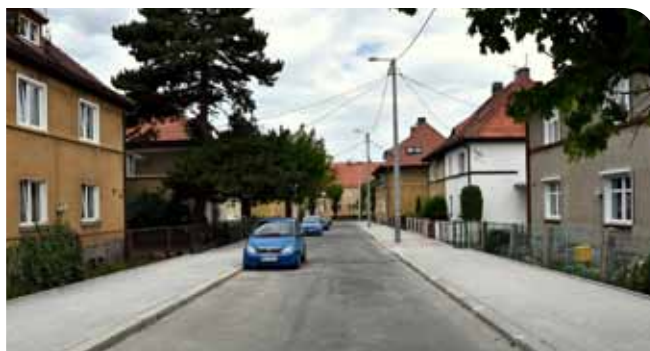
Przebudowa chodników wzdłuż ul. Lipowej. Koszt inwestycji – 85 tys. zł
