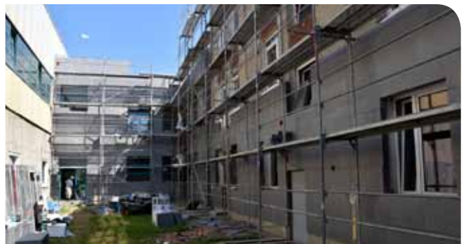
Termomodernizacja hotelu i zaplecza hali Ośrodka Sportu i Rekreacji . Koszt inwestycji - 706 tys 265 zł, pozyskane środki – 986 tys. zł
