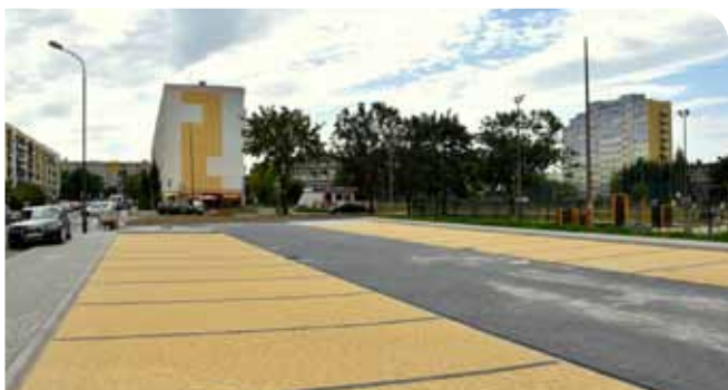
Budowa parkingu przy Alei Bajkowych Gwiazd. Koszt inwestycji – 380 tys. zł
