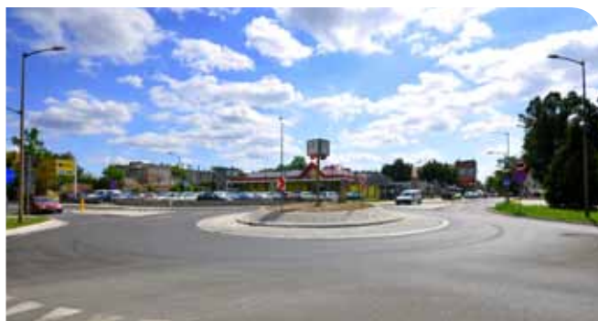
Budowa ronda na skrzyżowaniu ul. Piłsudskiego i Daszyńskiego.
