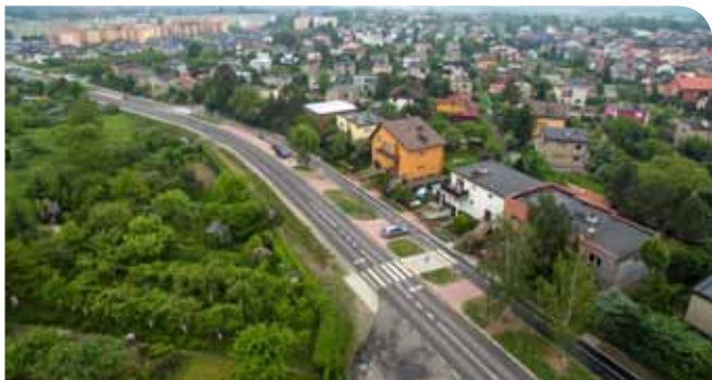
Przebudowa ul. Złotej i Akacjowej. Koszt inwestycji – 5 mln 294 tys. zł, pozyskane środki – 2 mln 961 tys. zł
