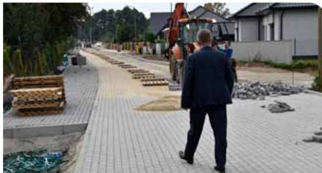
Przebudowa ul. Armii Krajowej. Koszt inwestycji – 757 tys. zł
