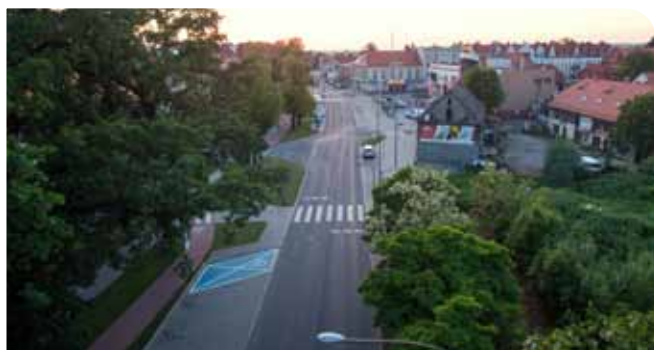
Przebudowa ul. Piłsudskiego.
