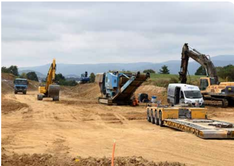
Budowa obwodnicy ma zmniejszyć ruch w centrum miasta, a tym samym ilość zanieczyszczeń emitowanych do powietrza
