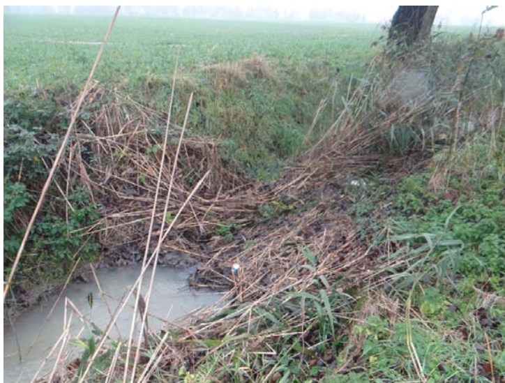
Ryc. 261. Zator z liści i sitowia na rowie przyroźnym
