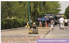
Zalocznia parkingowa na os. Różanym
