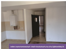
Jeden z wyremontowanych lokali mieszkalnych przy ulicy Żąbkowickiej 31
