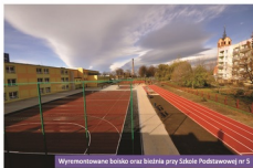
Wyremontowane boisko oraz bieżnia przy Szkole Podstawowej nr 5
