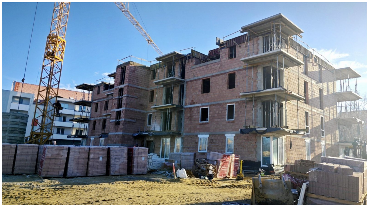
Fot: W czerwcu 2024 r. rozpoczęła się budowa kolejnego budynku wielorodzinnego DTBS-u, przy ul. Sowiogórskiej.
