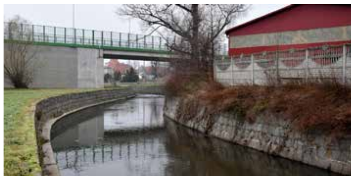
Czyszczenie koryta rzeki Piławy polegało na usuwaniu z dna nagromadzonego osadu, samosiejek drzew i krzewów
