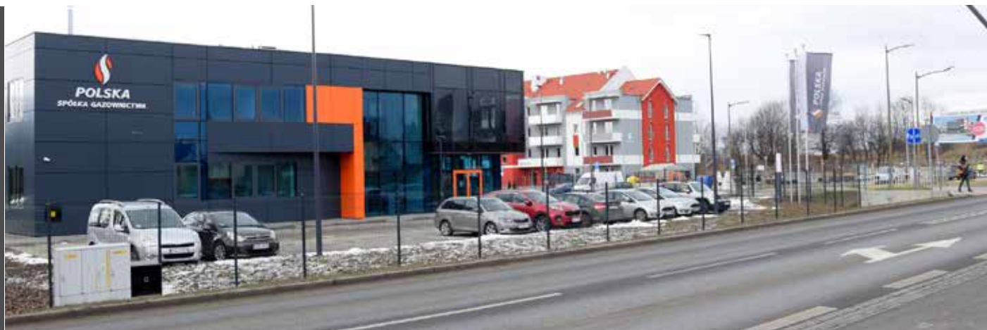
Przy ul. Sowiogórskiej oprócz nowych lokali mieszkalnych swoje miejsce znalazł też budynek administracyjny Polskiej Spółki Gazownictwa
