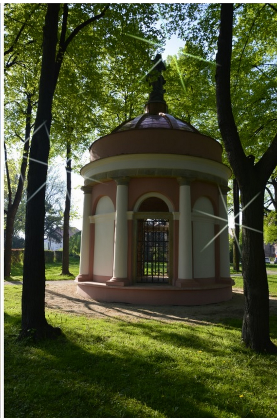
Před a po modernizaci
