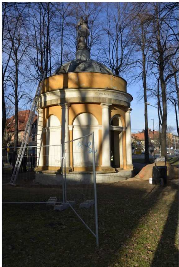
Przed i po modernizacji
