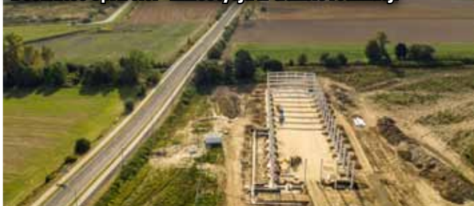
Beewatec Sp. z o.o. - inwestycja w trakcie realizacji
