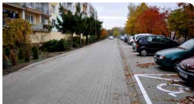
Przebudowa dróg na os. Tęczowym (wzdłuż budynków 6, 7, 8, 9, 10, 11-17, 24-25) oraz budowa ul. Srebrnej i ul. Szafrinowej.
