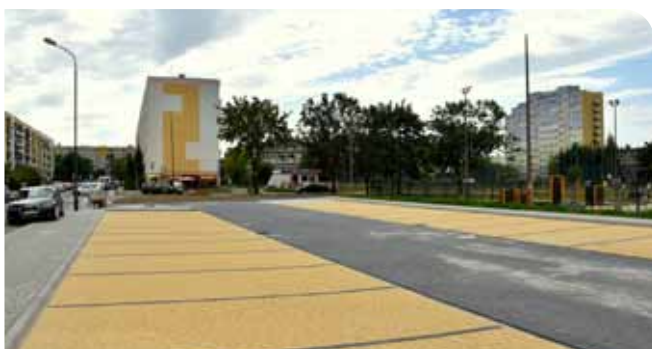
Budowa parkingu przy Alei Bajkowych Gwiazd. Koszt inwestycji – 380 tys. zł
