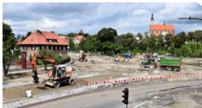
Przebudowa ul. Batalionów Chłopskich (od mostu przy młynie do ul. Wierzbowej). Koszt inwestycji – 1 mln 800 tys. zł, pozyskane środki – 1 mln 126 tys. zł
