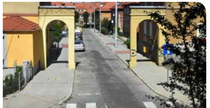
Budowa chodników wzdłuż ul. Marszałkowskiej. Koszt inwestycji - 102 tys. zł
