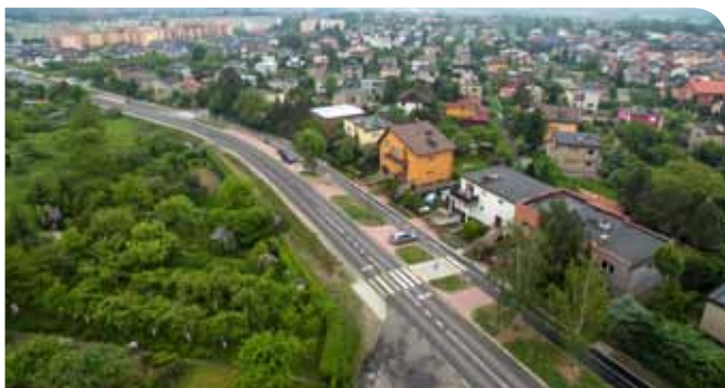
Przebudowa ul. Złotej i Akacjowej. Koszt inwestycji – 5 mln 294 tys. zł, pozyskane środki – 2 mln 961 tys. zł
