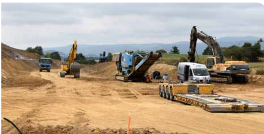
Budowa obwodnicy ma zmniejszyć ruch w centrum miasta, a tym samym ilość zanieczyszczeń emitowanych do powietrza
