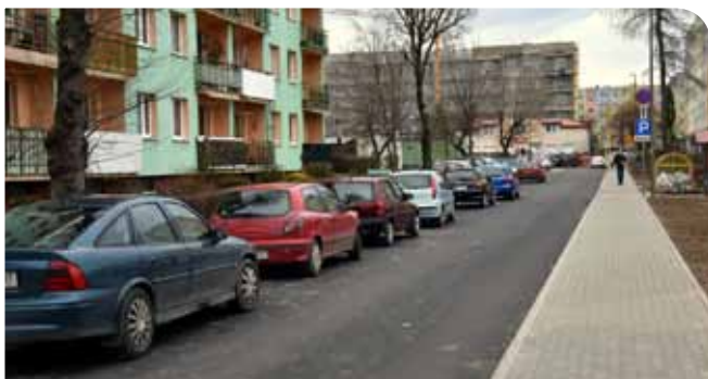
Przebudowa tęcznika na os. Różanym (od ul. Sikorskiego, do budynków 4 i 5). Koszt inwestycji – 389 tys. zł
