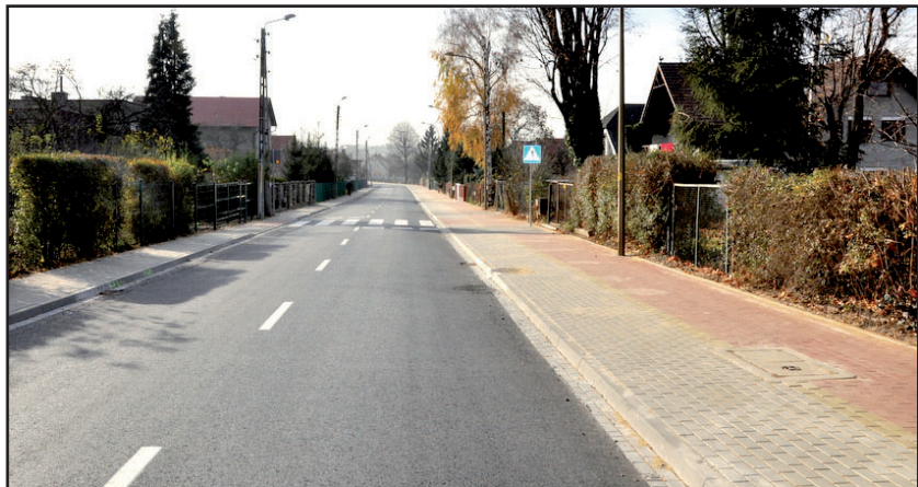
W ramach inwestycji wyremontowano kilometr drogi, powstały także nowe chodniki i oświetlenie
