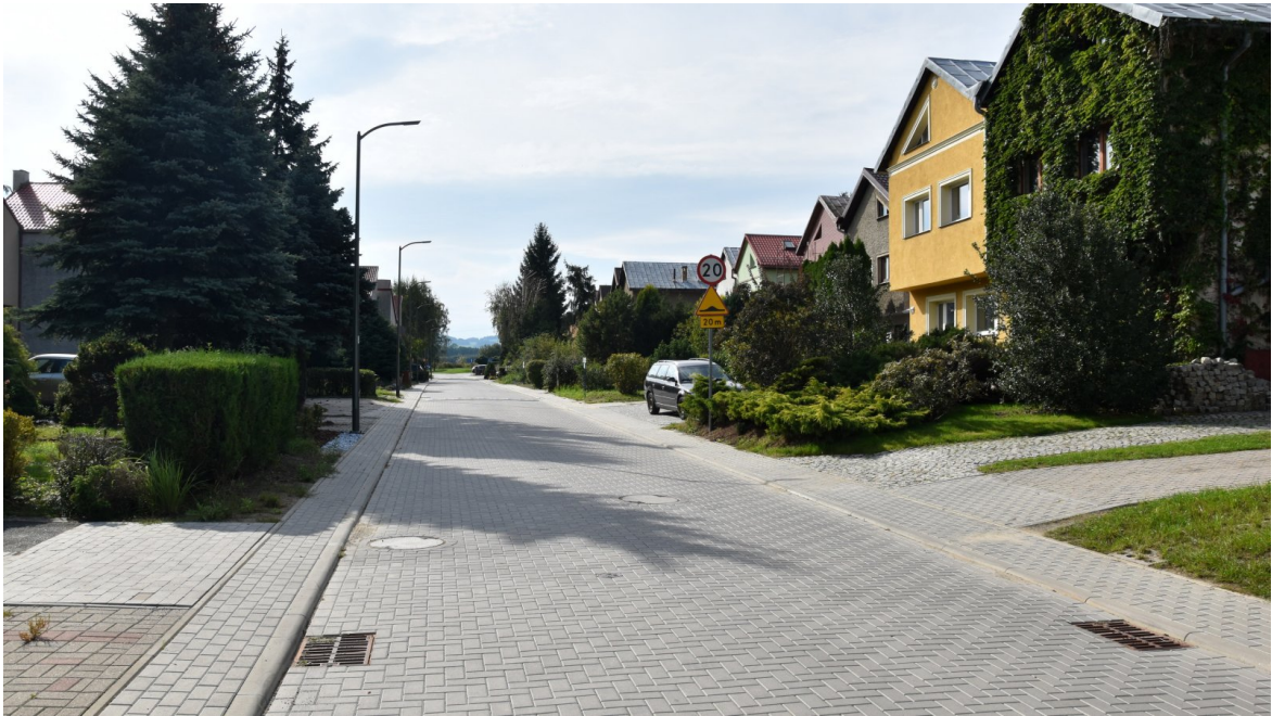
Ul. Henryka Wieniawskiego po przebudowie zakończonej w 2024 roku.
